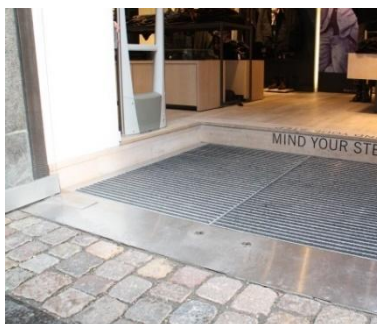
Plant golv, klar til på-/avkjørsel
