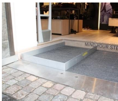
Sikringsplater kjørt opp
